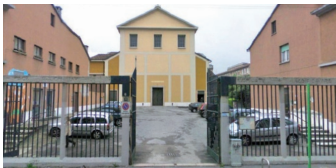
La chiesa prima e dopo l'intervento.
