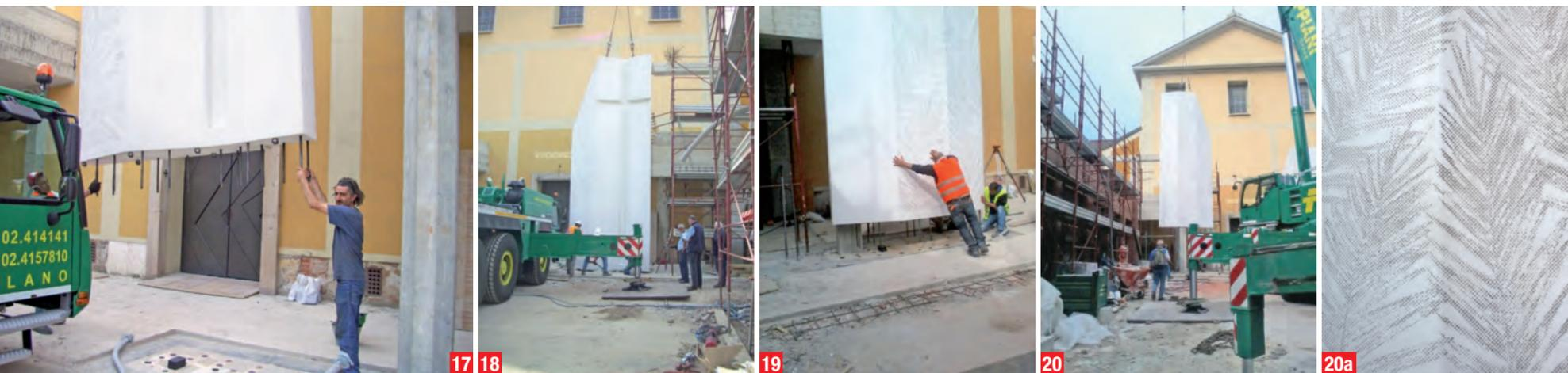
**13-14-15-16-17-18-19-20-20a. Arrivo, sollevamento, raddrizzamento e posizionamento dei pannelli del portale predisposto in sei pezzi verticali nel laboratorio della ditta Styl-Comp spa di Bergamo tramite dei casseri metallici che ne hanno determinato la levigatura satinata della superficie. Dettagli della serigrafia su calcestruzzo.**
